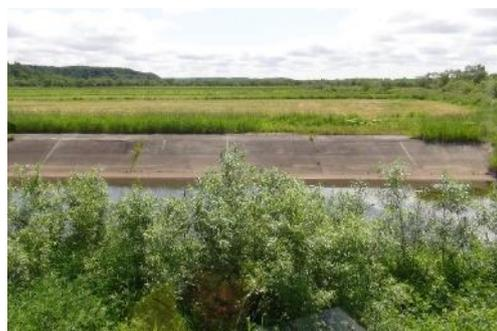
しなくなっていくので、定期的に堆積した砂を陸に上げる作業をしている。排水路は温根内川にぶつかりが、合流点の直前にこの沈砂池がある。今から温根内川沿いを久著呂川方面に行き、温根内川と久著呂川の合流点を抜けると、目的のフィールドに到着となる。なお、こういった沈砂池は流域では他にも多く設置されており、新庄さんがおっしゃったように、こういった機能を果たしていけるかということモニタリングしながら運営している状況と聞いている。
