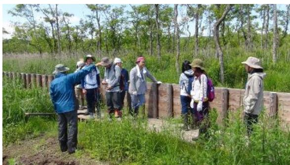
地下水へと抜けて、土砂だけが残る。ここに生えている植物がフィルターの役目となり、土砂だけでなく上流部から運ばれてくる富栄養の養分も吸収し、きれいな地下水となって出てくる効果を期待している。この湿原の植物の持っている水の浄化作用と、洪水をコントロールする洪水調節機能という 2 つの自然の機能を期待した取り組みである。この衝立の見た目は非常にシンプルだが、泥炭の下まで杭を打ち込まなくてはいけないため、2m～3mほど打ち込んでいる。将来、それらの機能がどれくらい有効であるかを植生の変化を見ながらチェックしていこうと取り組んでいる。土砂が入り込む、富栄養のものが入り込むことでこの湿原の植物がどのように変化していくかを、これから行く場所で見たいと思う。
